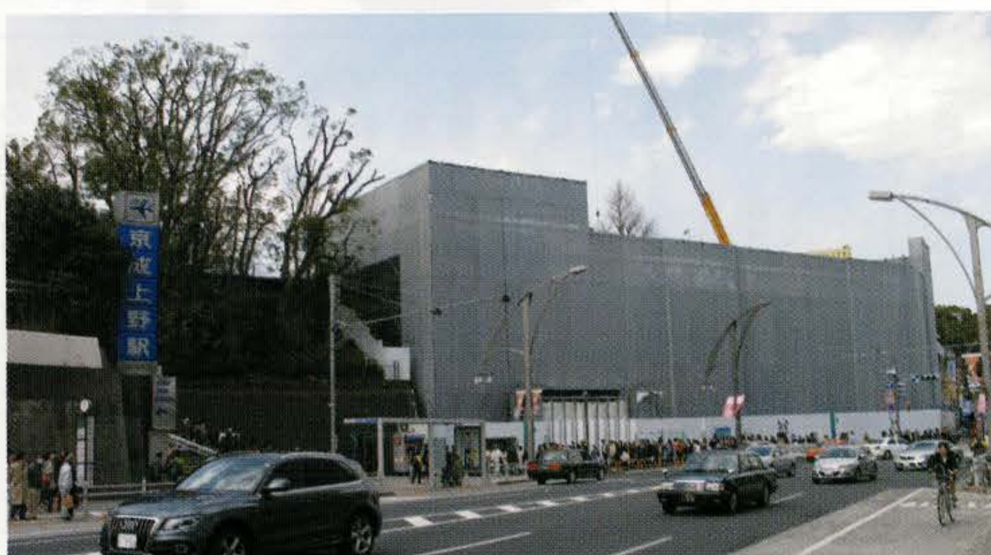
工事が進む上野西郷会館
